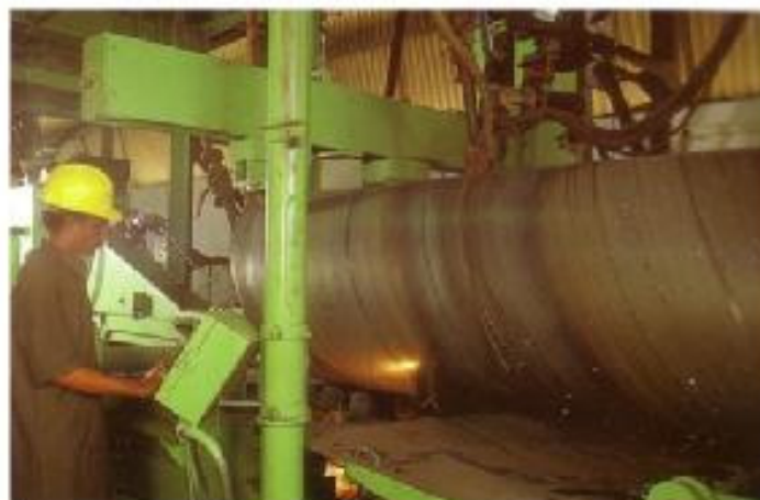
شکل ۱۲-۳ عملیات جوشکاری داخلی و بیرونی درز لوله
